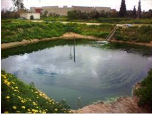
الصورة 9: حوض الشحن الاصطناعي للمائدة الجوفية بالمياه المستعملة المعالجة – محطة التجارب بواد سوحيل، نابل
